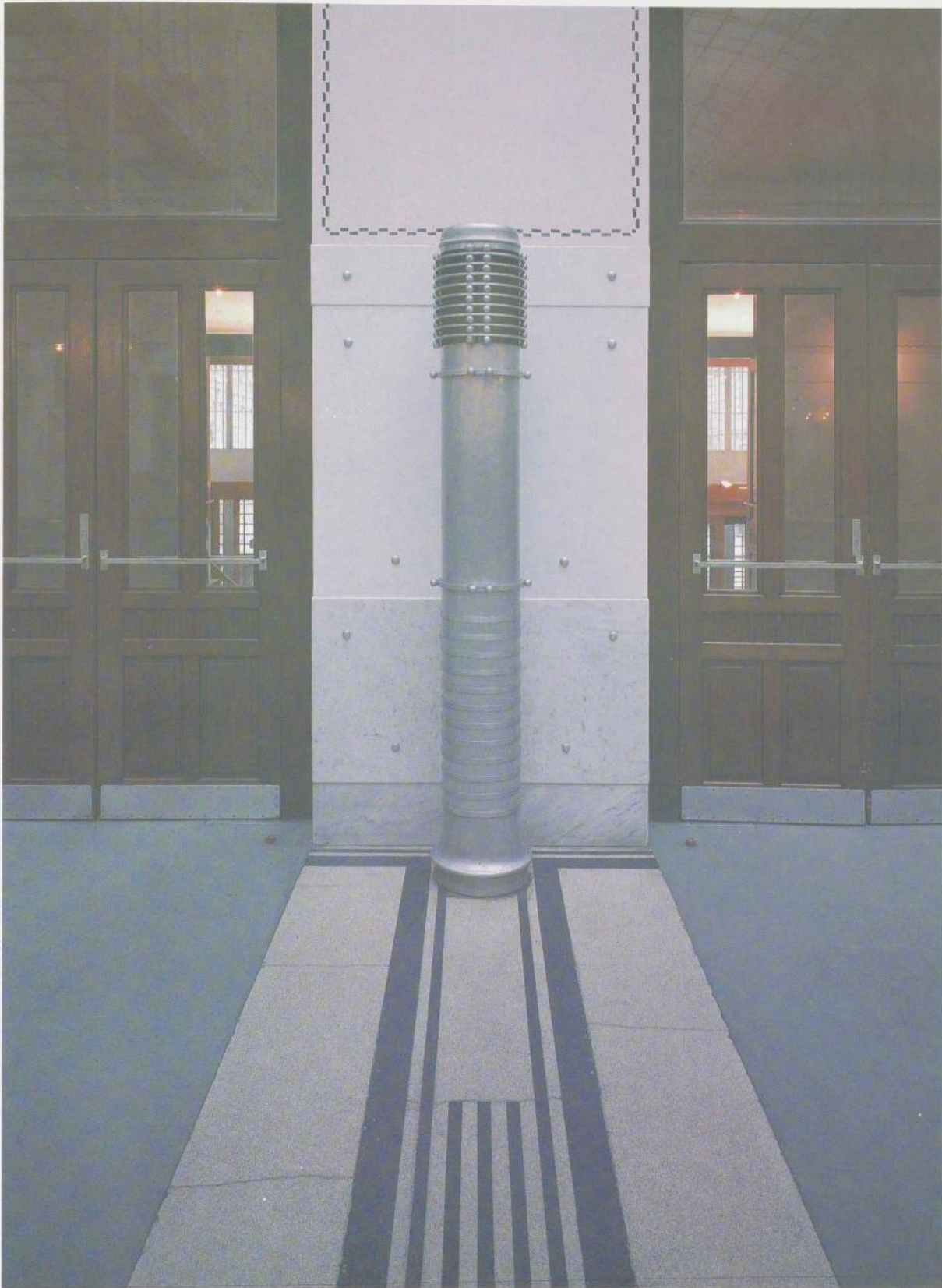
Otto Wagner. Warmluftausbläser in der Haupthalle, Postsparkassenamt. Um 1906. Aluminium, 250 cm hoch. Österreichische Postsparkasse, Wien.
