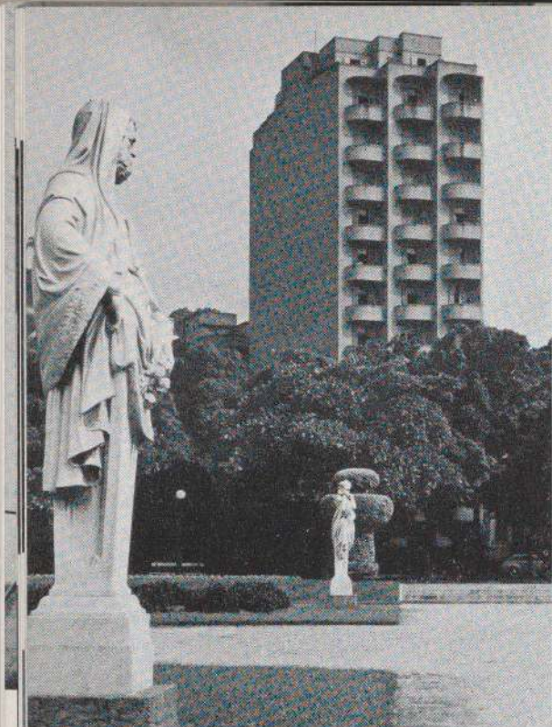
Apartments, Avenida Augusto Servero, 78, Rio de Janeiro
